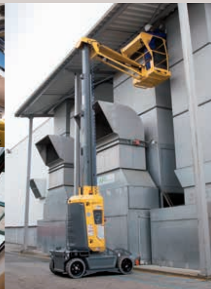
MAINTENANCE ET TRAVAUX DE SECOND ŒUVRE EXTÉRIEUR (éclairage, signalisation, réparation...)
