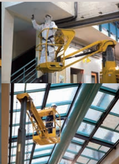
TRAVAUX DE SECOND ŒUVRE INTÉRIEUR (électricité, éclairage, plomberie, peinture, climatisation, tuyauterie, système de détection incendie...)
